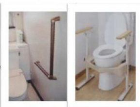
トイレ用手すり 住宅改修するもの(左) と設置型(右)があり
